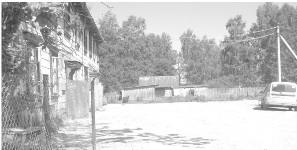
Дворовая территория ул. Депутатская после благоустройства
